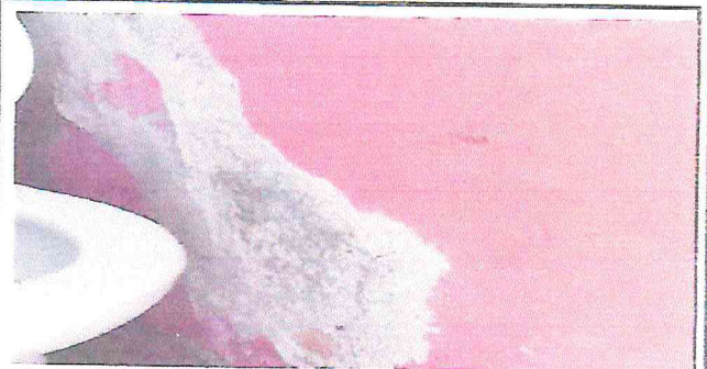
Foto 4: estructura de paredes en mal estado por el paso del tiempo y accesorios en general en mal estado.
